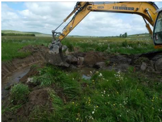
Travaux en zone humide, CEN Lozère
