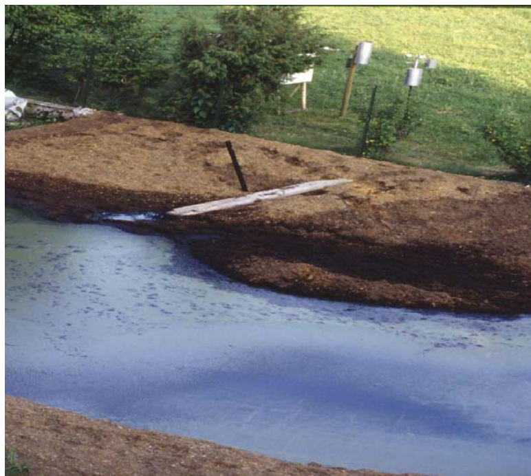
Création de tourbière en fibre de coco. Photo : Centre Nature Les Cerlatez
