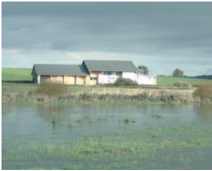
Station d'épuration du Drugeon - JN Resch (CFD)
